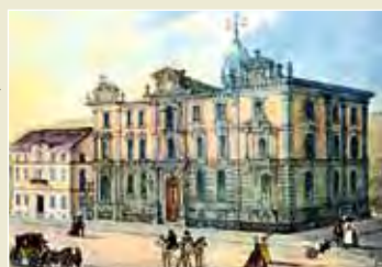
Büros der Bank in Winterthur 1862.
